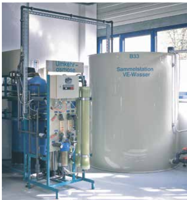
УСТАНОВКА ОБРАТНОГО ОСМОСА С ПРЕДВАРИТЕЛЬНЫМ УМЯГЧЕНИЕМ
